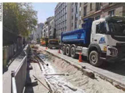
Travaux de végétalisation des rues à Paris 13*
