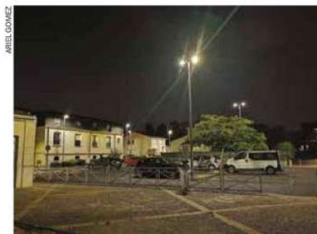
La rénovation de l'éclairage public (ici à Talence, ville totalement équipée en LED piloté) sont de plus en plus intégrés dans d'autres travaux.
