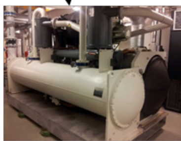
Figure 4 : Schéma de production par Groupe Froid eau-eau
